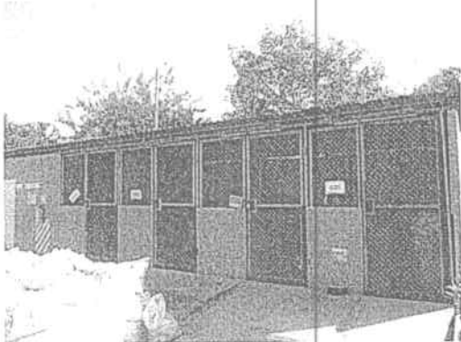
Foto 9. Zona de almacenamiento de residuos. Ventilada, rotulada.
